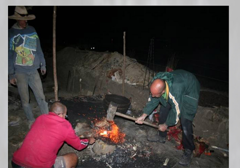
18. kép: Buca tömörítése
