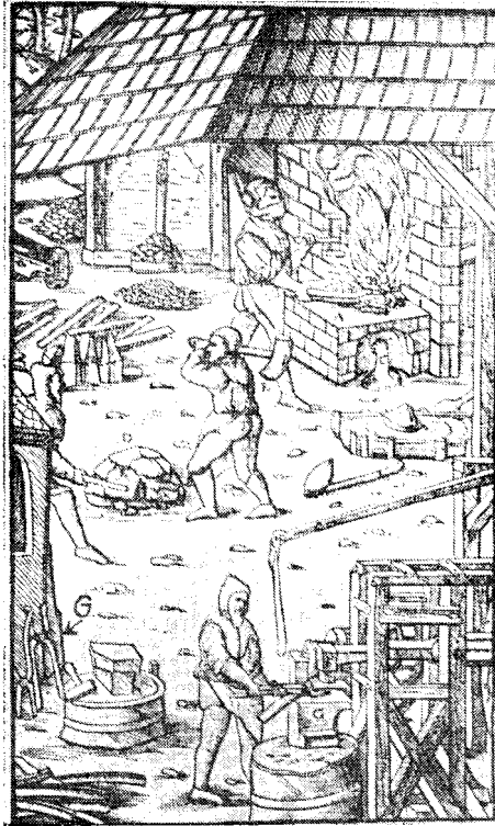
5. ábra. Olvasztógödör üzem közben Agricola: De Re Metallica c. könyvéből
